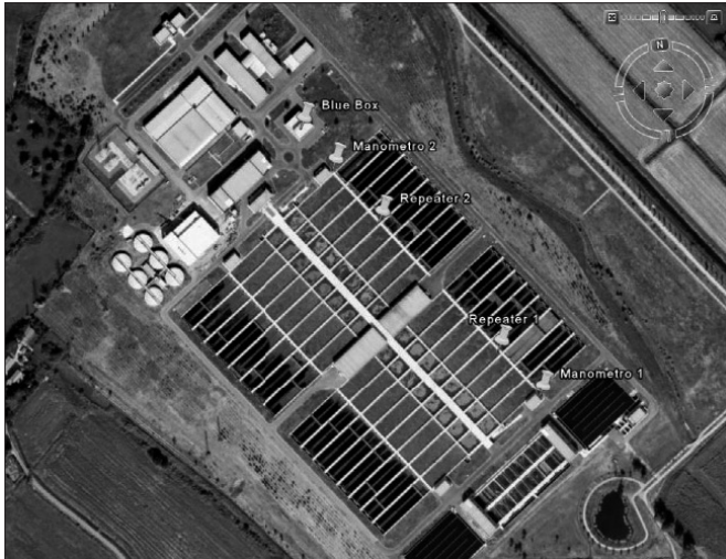
Fig. 2 – Soluzione Wireless presso il Depuratore di Nosedo per il monitoraggio delle stazioni di pompaggio
